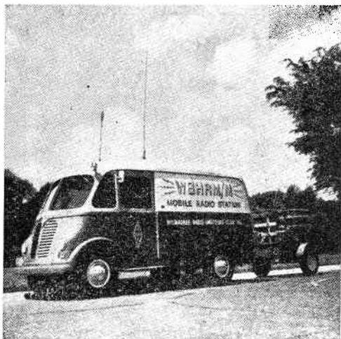
**Organizzazione.** Questo aut furgone appartiene al Milwaukee Radio Amateur Club e contiene una completa apparecchiatura ricevente-trasmittente per le bande radiantistiche dei 2, 10 e 75 metri. Il nominativo di questa stazione mobile è W9HRM/M.
